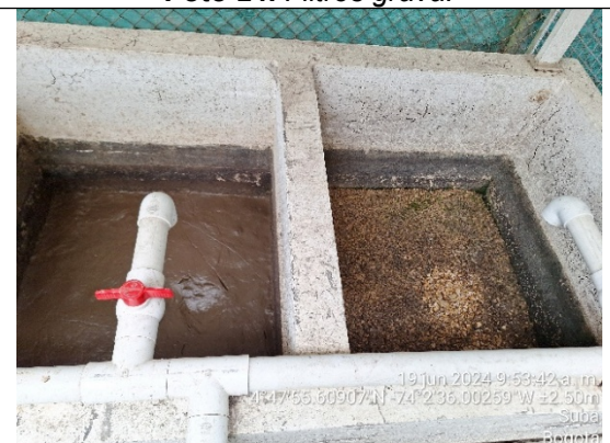
Foto 26. Secado y retorno de lodos.
