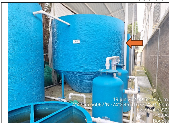
Foto 23. Sedimentador secundario
