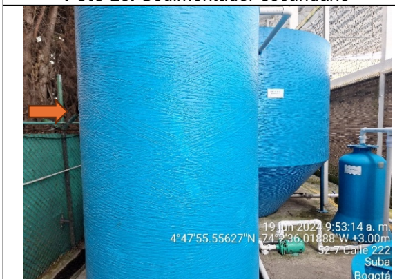
Foto 25. Tanque de desinfección
